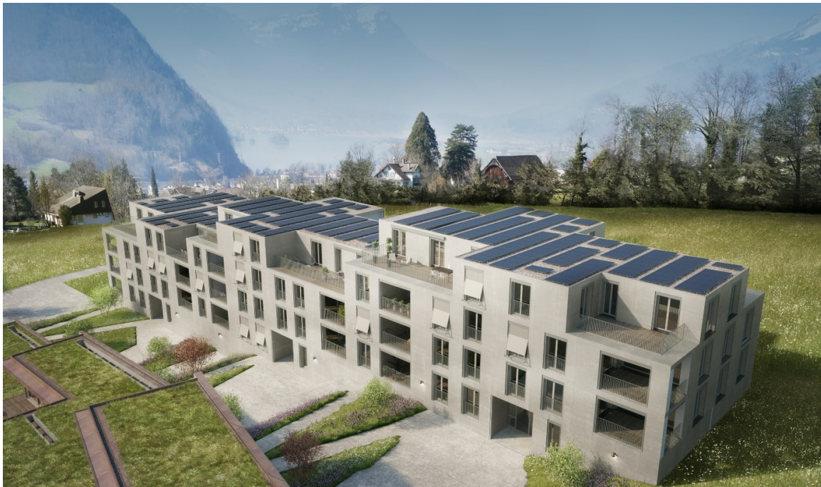
Abbildung 16 Siedlung Mättivor, Schwyz: Strom und Mobilität als ganzheitlicher Ansatz mit Batteriespeicher und E-Fahrzeugladestationen verbunden mit Gebäudeautomation, abgerechnet über ein integriertes Cloud System für das Contracting geliefert von der ecocoach AG. Bildquelle: Cimag AG/ nightnurse images
